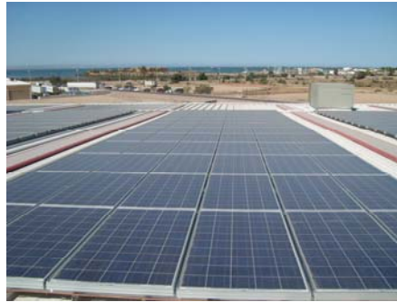
SAM'S Club Baja California Potencia Instalada 200kW Módulos Solares 1215
